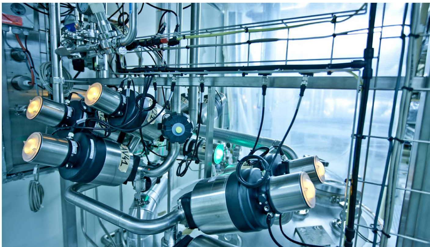
Válvula de diafragma tipo 2103 con cabezal de control tipo 8691 en una sala blanca de Novo Nordisk
